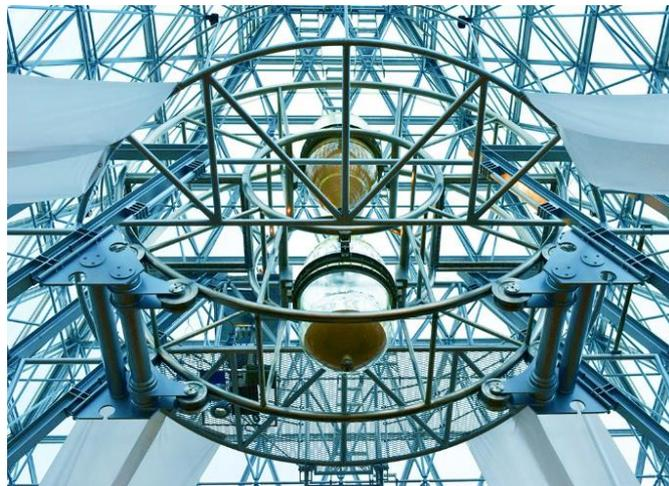
この砂時計は、島根県仁摩(にま)町にあります。皆さんも3分計や、5分計といった砂時計というものを持っている人もいるかもしれませんが、この町にある時計は1年計の砂時計。1秒間に0.032g、1日で2,740gの砂が、わずか直径0.84mmのノズルから流れ落ち、1年かかって砂がすべて落ち切る時計なのです。全長5.2m、直径は1mというジャンボ容器を使い、その中を1トンの砂が音もなく時を刻んでいるのだそうです。
